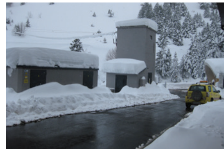
Tunel Bielsa (Španělsko-Francie)
